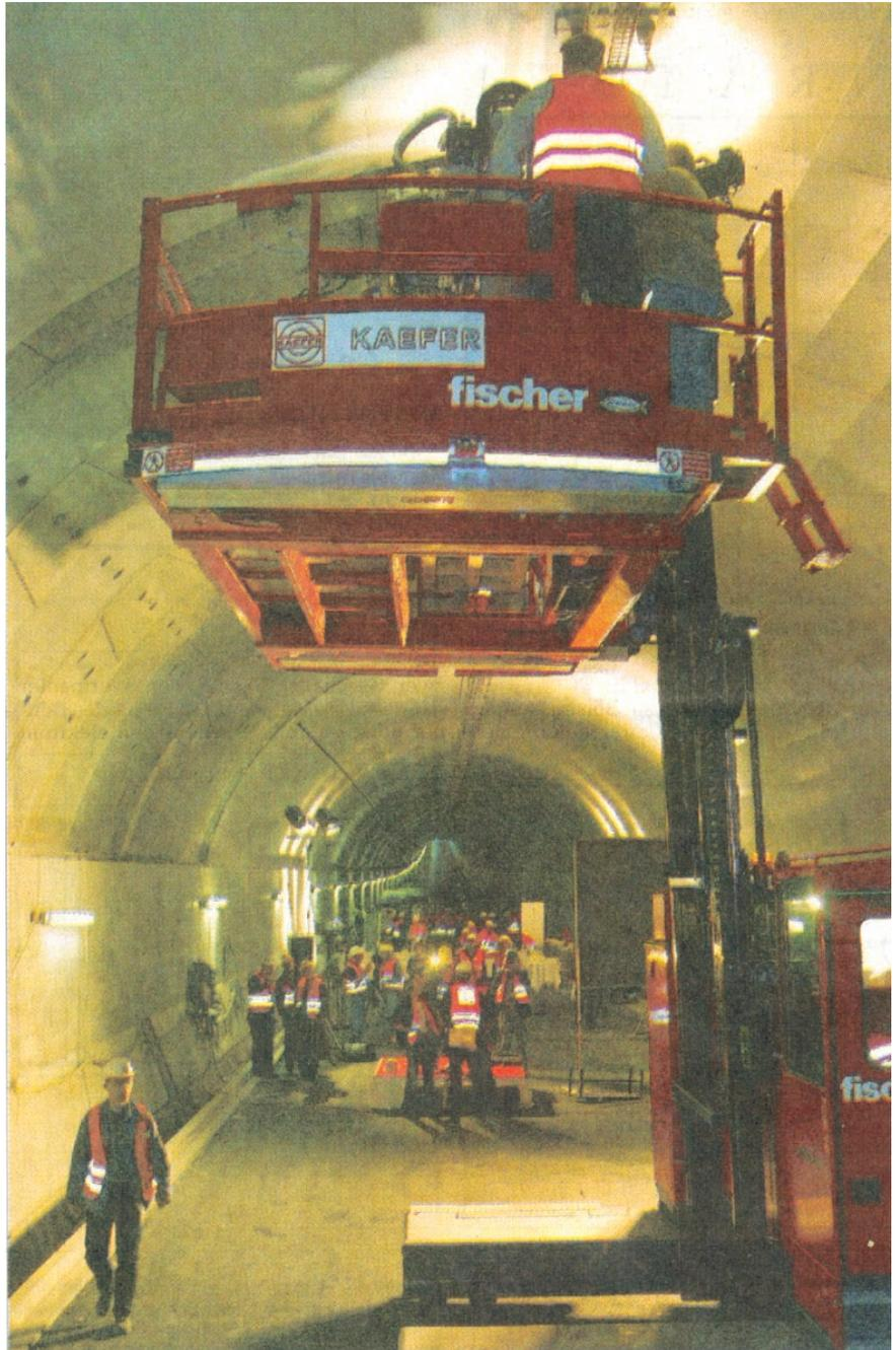
Ein neuartiger Tunnel-Roboter verlegt im Wesertunnel zwischen Kleinensiel und Dedesdorf die Brandschutzplatten. Die Fachleute sind zur Kontrolle da.
